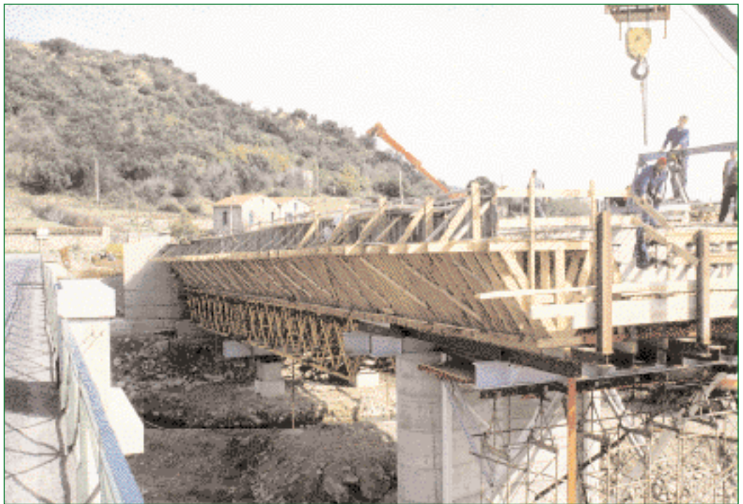
Construction d'un nouveau pont à Ille-sur-Têt : les anciens ouvrages d'art sont souvent inadaptés au passage des grumiers.
