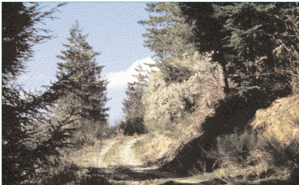
La desserte forestière est fondamentale pour valoriser la ressource ligneuse, notamment les plantations qui arrivent en production.
